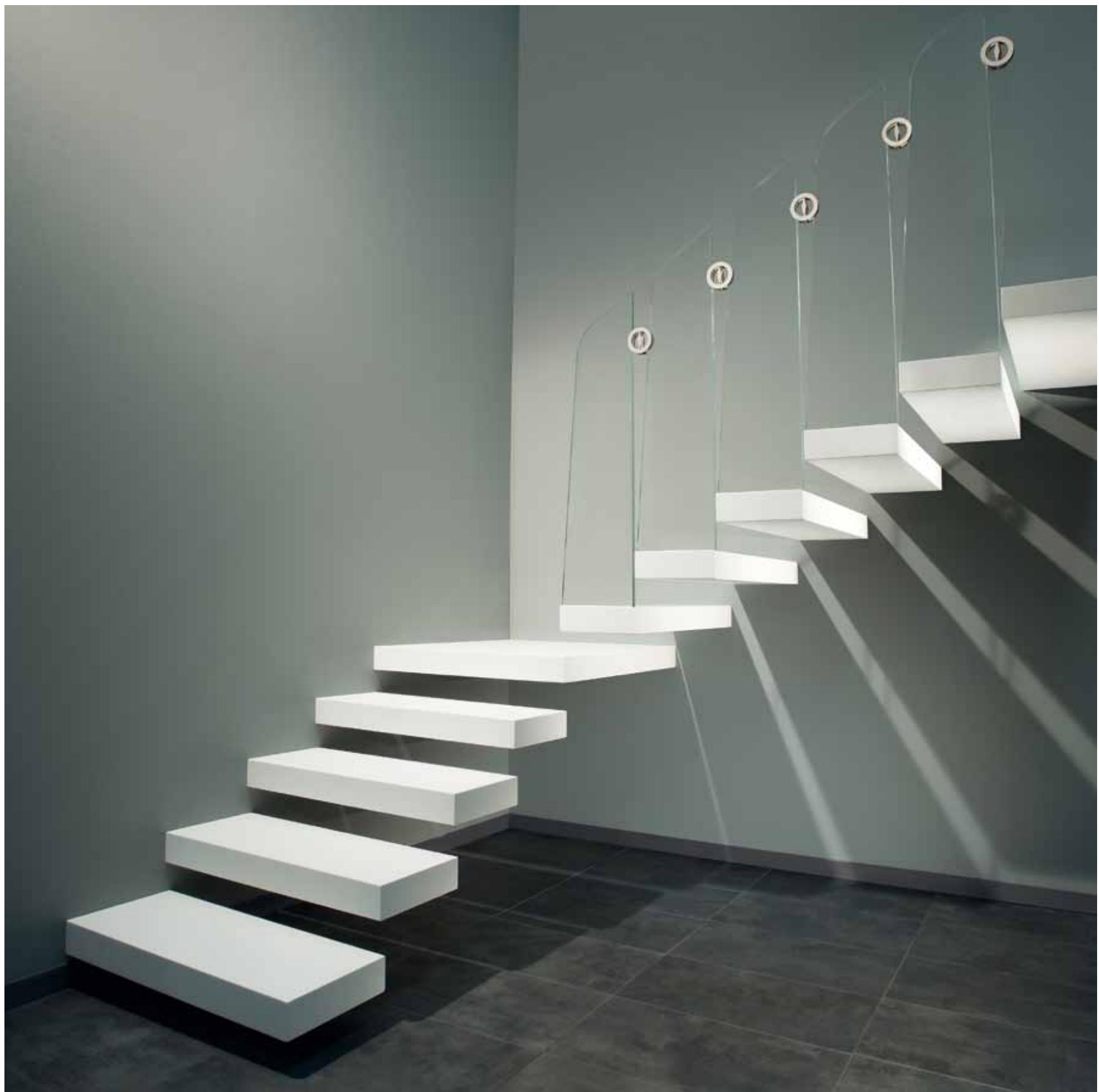
Scala a sbalzo a giorno modello "Vela" senza sostegno laterale rivestita in Corian.
