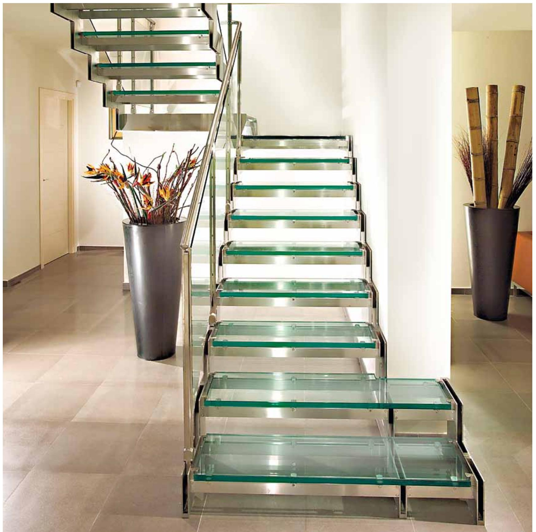
Scala a struttura laterale modulare in acciaio inox e gradini in cristallo stratificato float e ringhiera in acciaio inox e cristallo stratificato.
