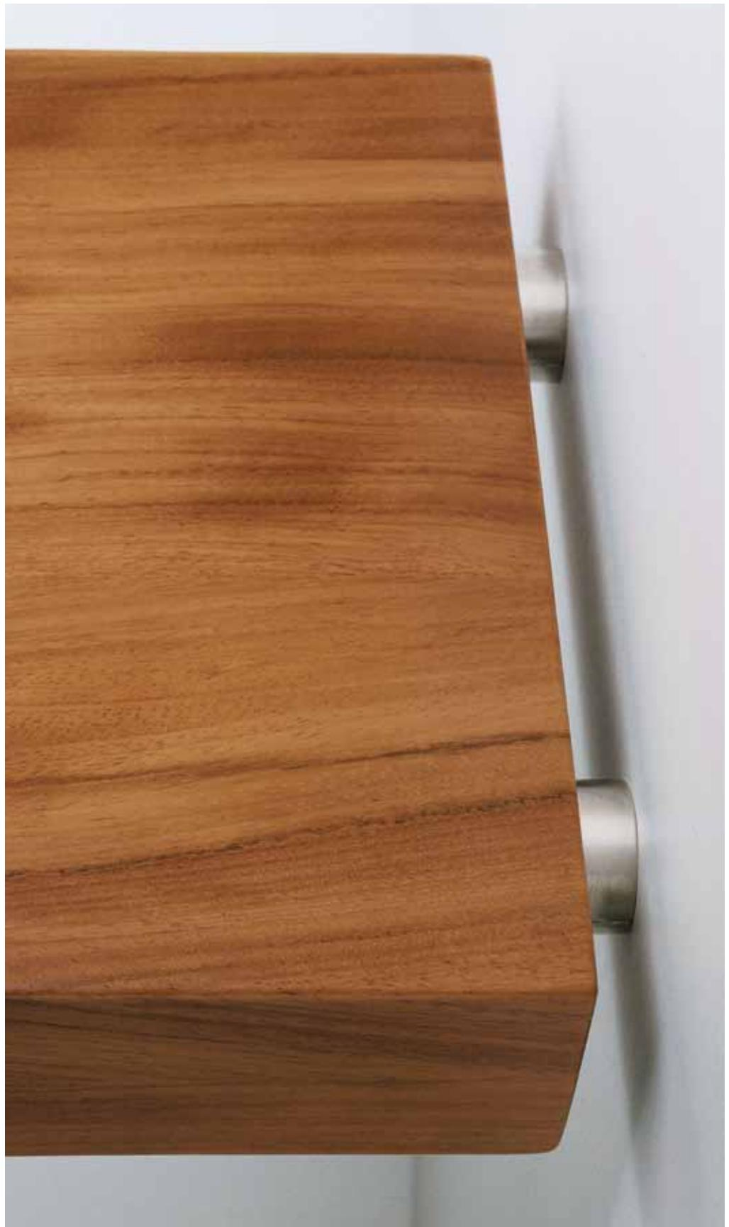
Particolare attacco al muro del gradino scala a sbalzo.
