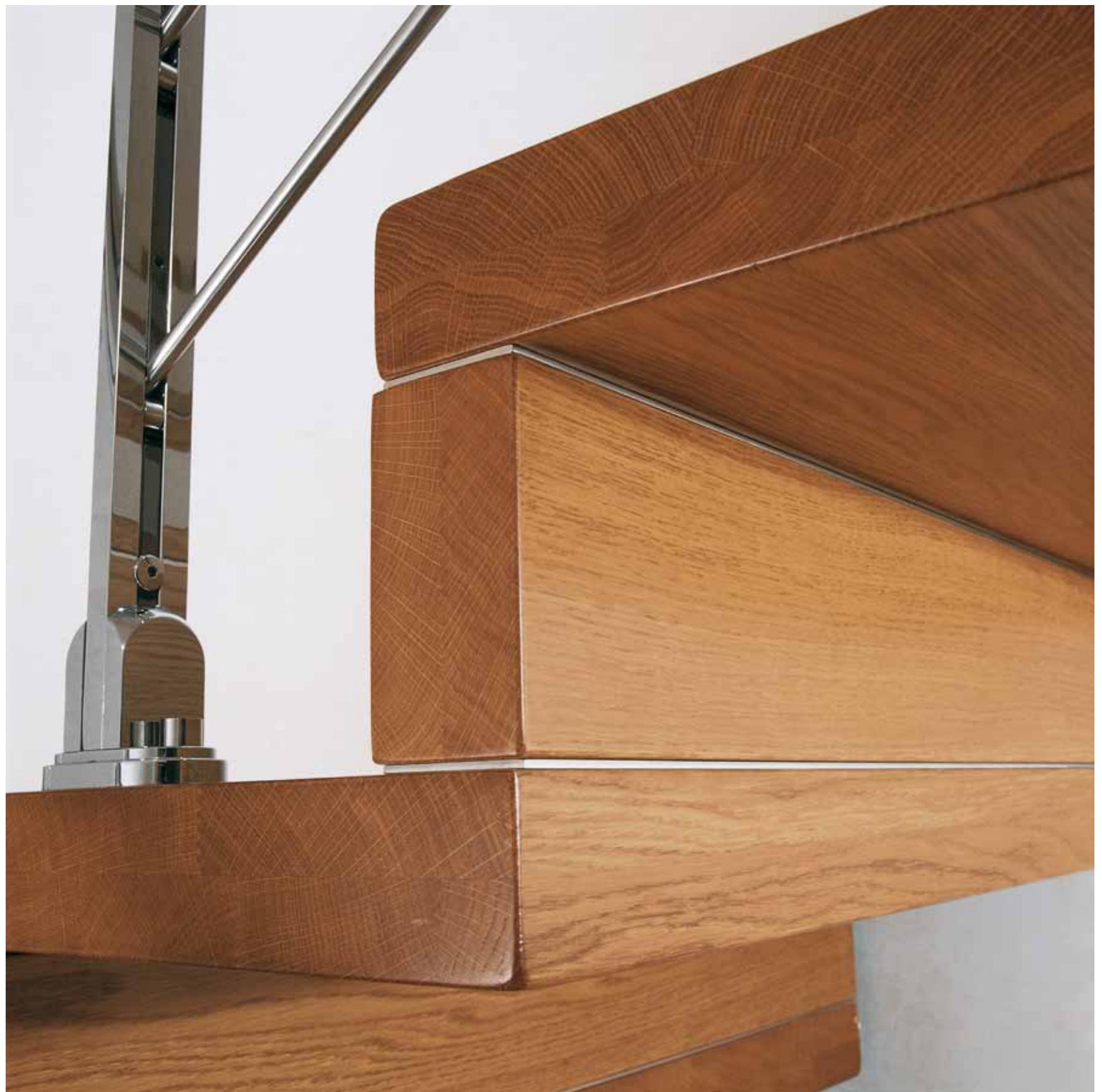
Particolare scala a sbalzo chiusa con inserti in acciaio inox tra gradino e sottogrado.
