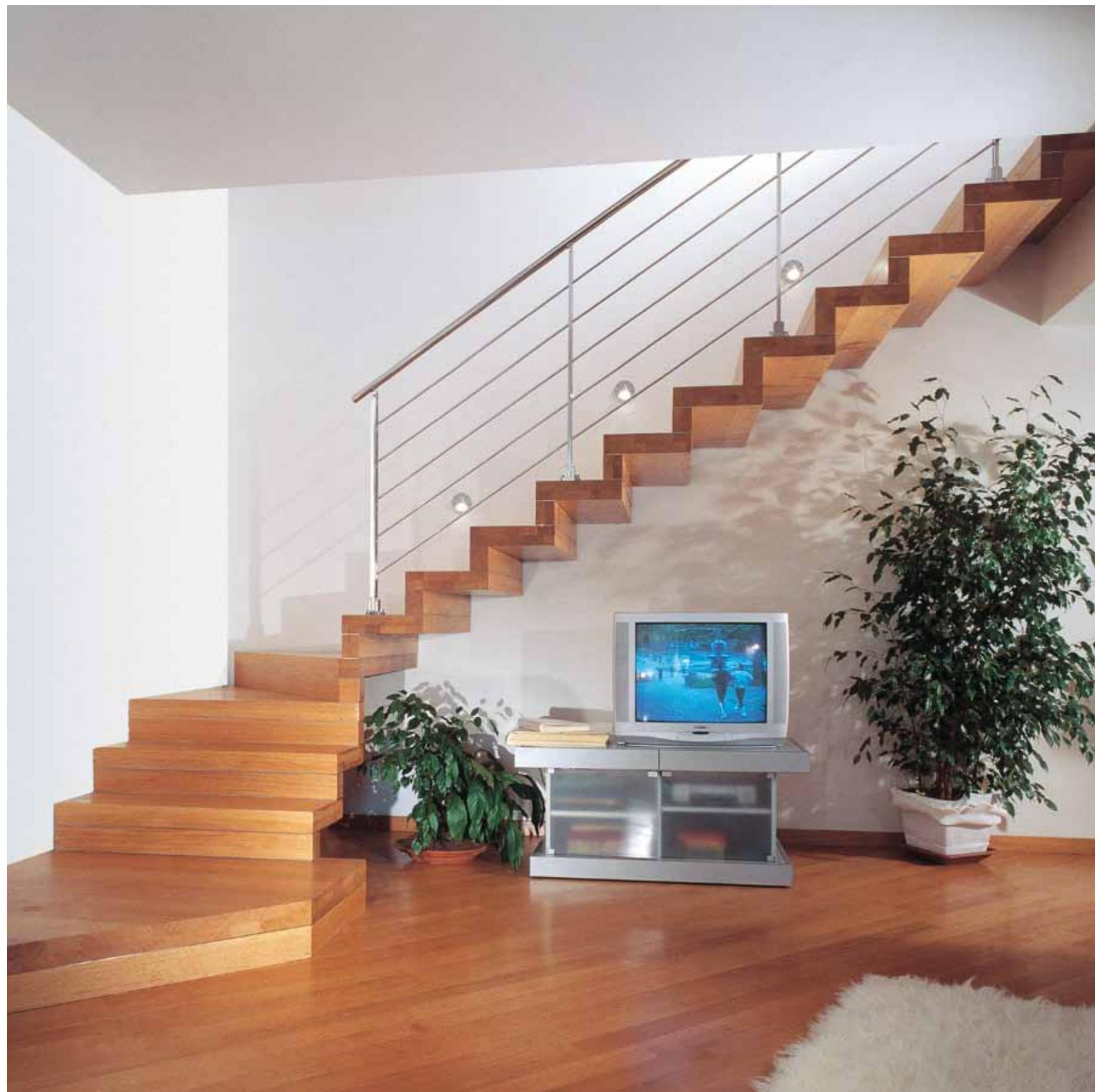
Scala a sbalzo chiusa con sottogrado in rovere massello e ringhiera a tondino orizzontale in acciaio inox.
