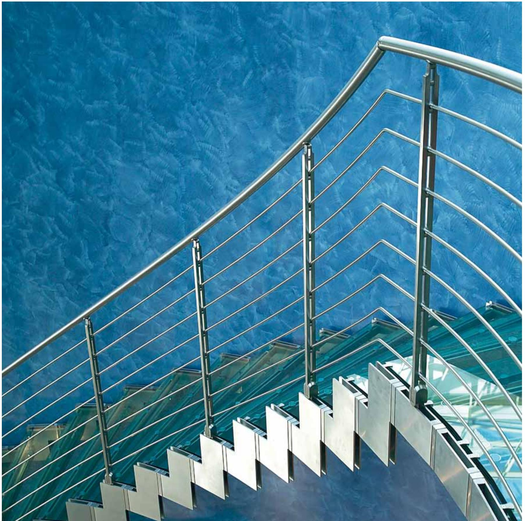
Scala elicoidale con struttura laterale modulare in acciaio inox e gradini in cristallo stratificato float e ringhiera a tondini orizzontali in acciaio inox.
