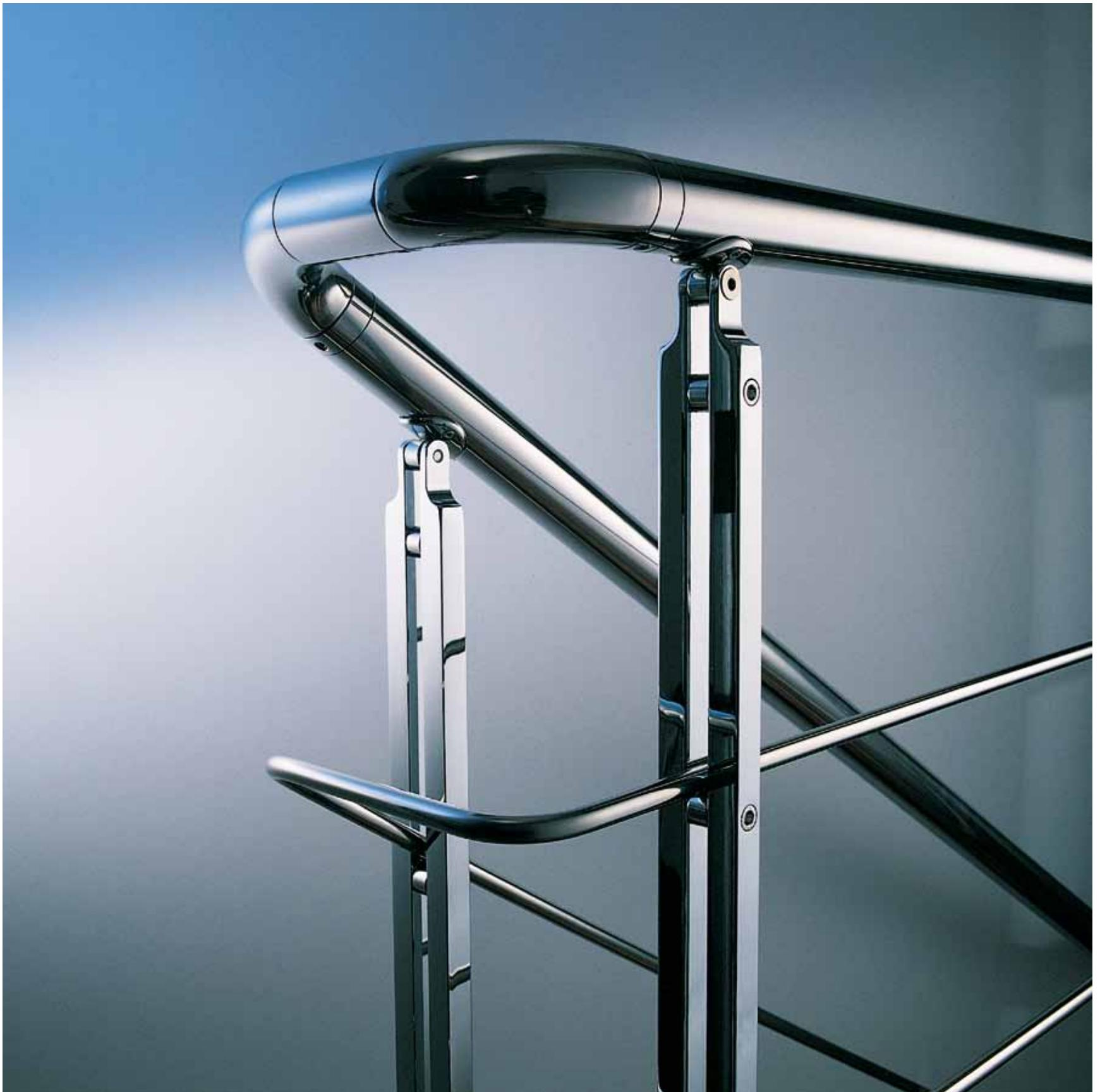
Particolare corrimano e tondini continui tra la rampa e il ballatoio in piano, in acciaio inox.
