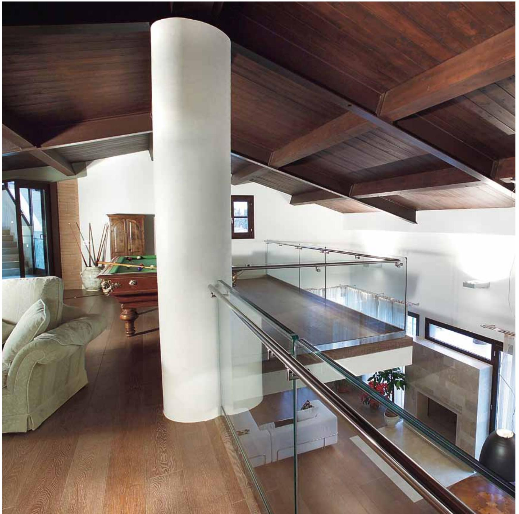
Ringhiera in cristallo strutturale con base e corrimano in acciaio inox.
