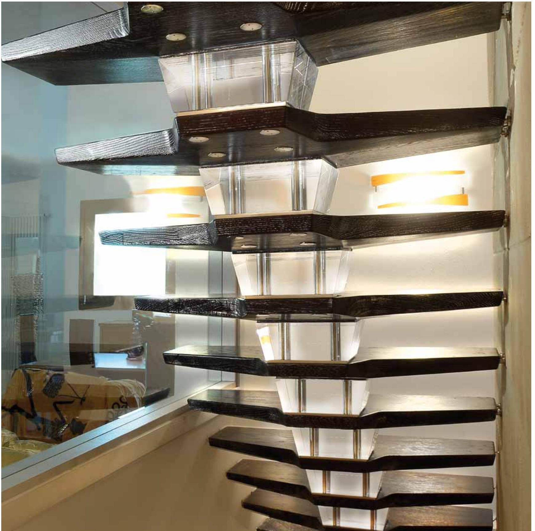
Scala componibile con gradini in massello di rovere ed elementi strutturali in plexiglass con sorgenti luminose.
