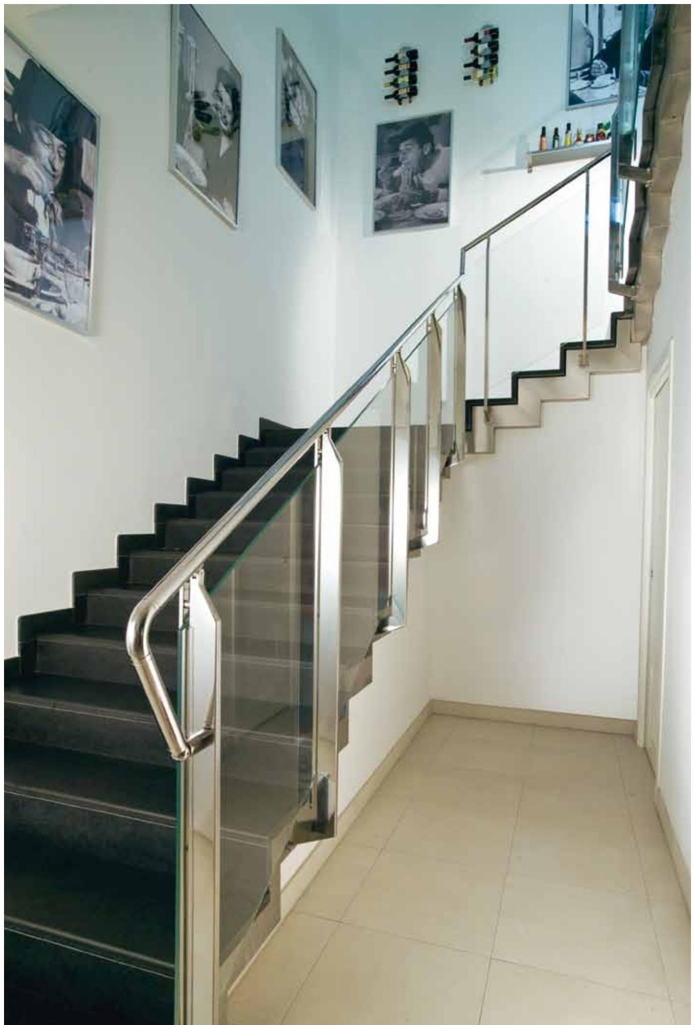
Ringhiera per esterno e interno con attacco fianco scala e cornicano in asse in acciaio aisi 316/314 con pannelli in cristallo stratificato extra-chiaro.
