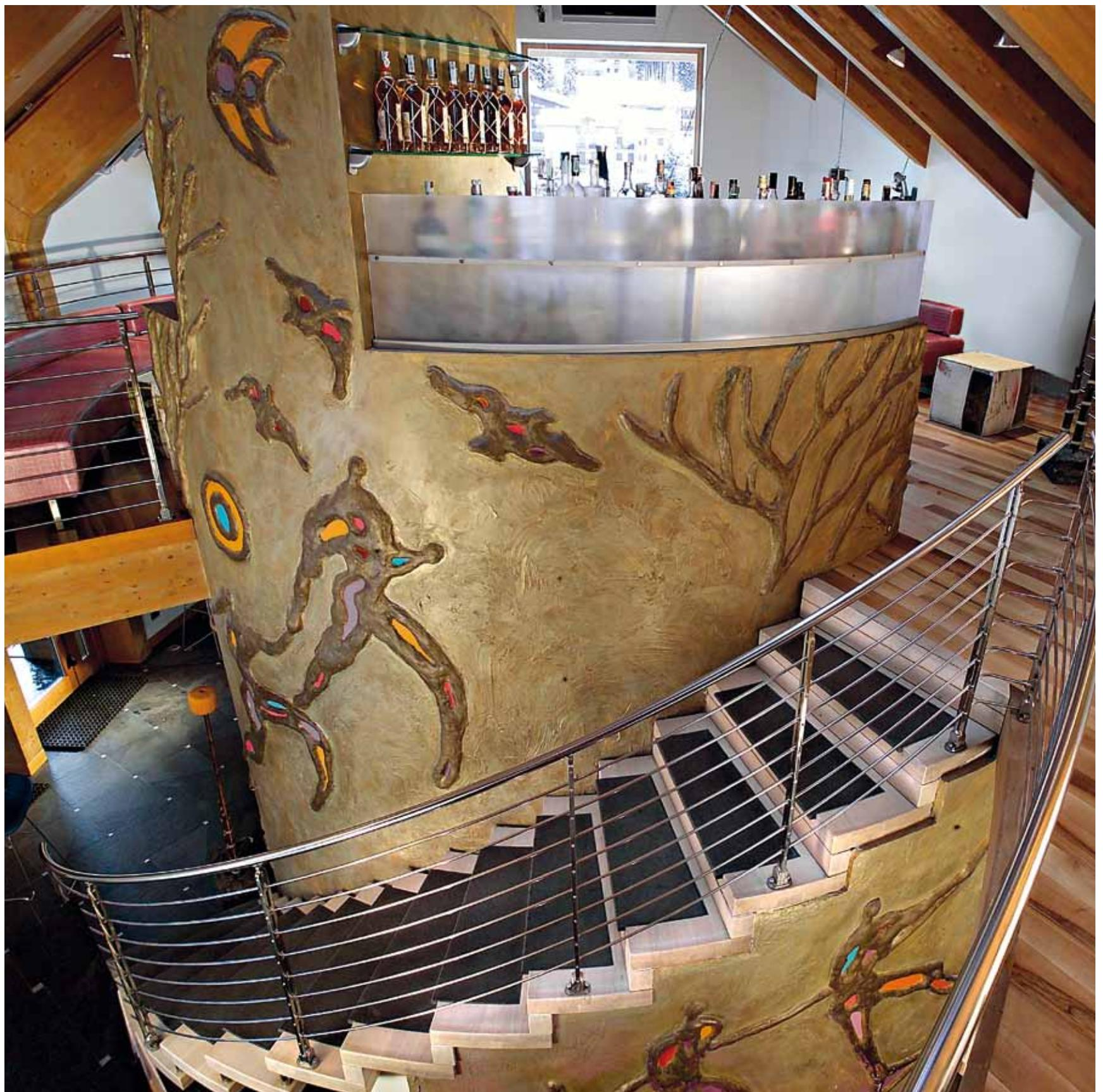
Scala a sbalzo con sottogrado e senza con gradini in rovere massello sbiancato e pedate con inserto in pietra e ringhiera a tondini orizzontali in acciaio inox.
